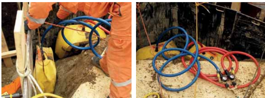
Obrázek 56, Vyplnění defektu vnitřního rohu výkopu pomocí nízkotlakých vaků [5]
