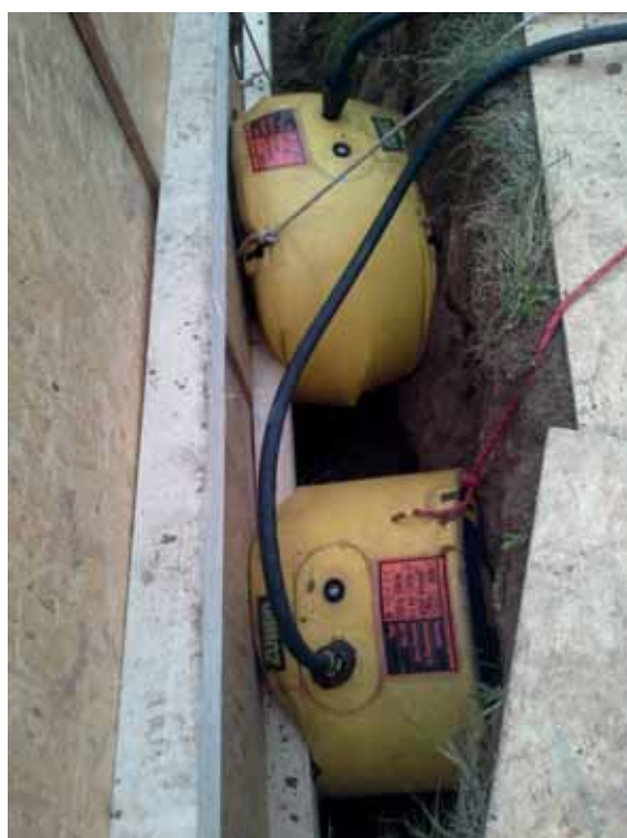
Obrázek 12, Nasazení nízkotlakých vaků k vyplnění defektu stěny výkopu [5]
