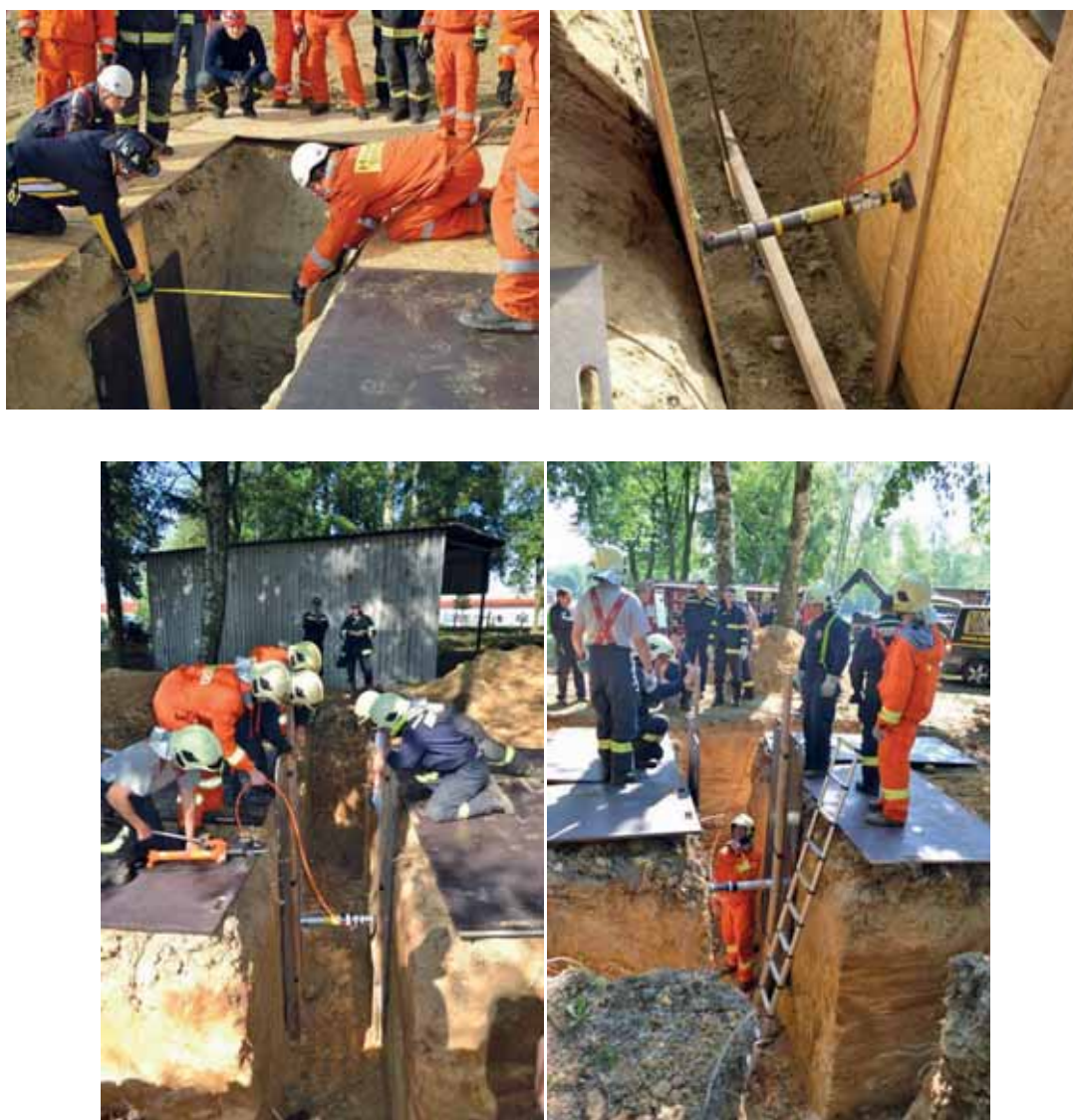
Obrázek 32, Určení délky a správné nasazení středové stabilizační tyče bez nutnosti vstupu do výkopu [5]
