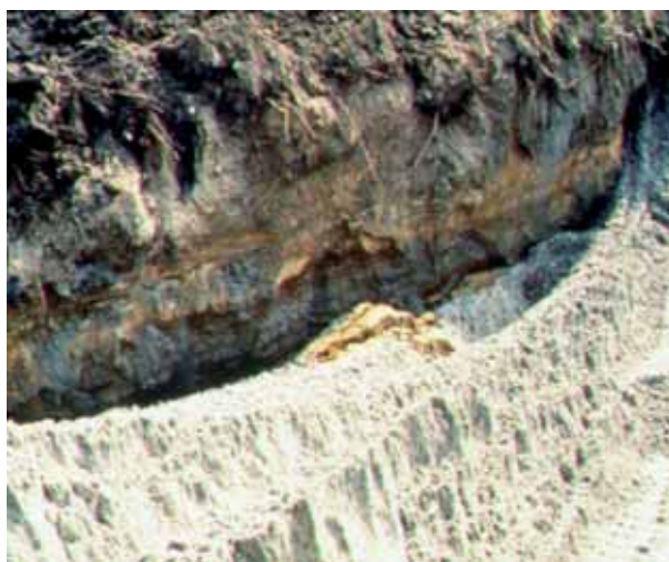
Obrázek 5, Ukázka skladby vrstev podloží [6]
