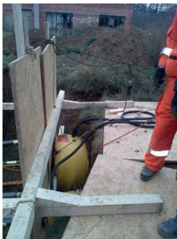
Obrázek 12, Nasazení nízkotlakých vaků k vyplnění defektu stěny výkopu [5]
