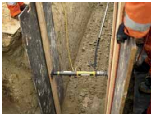
Obrázek 33, Nasazení středové stabilizační tyče do bednicí desky [5]
