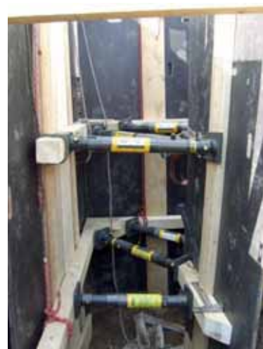
Obrázek 59, Konečná fáze stabilizace rohového výkopu [5]
