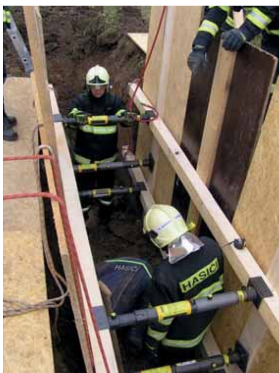
Obrázek 43, Nasazení vnitřních trámů zajišťuje možnost hlubokého kopání [5]
