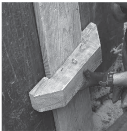
Obrázek 10, Nasazení dřevěných prvků při stabilizaci rohových výkopů [6]
