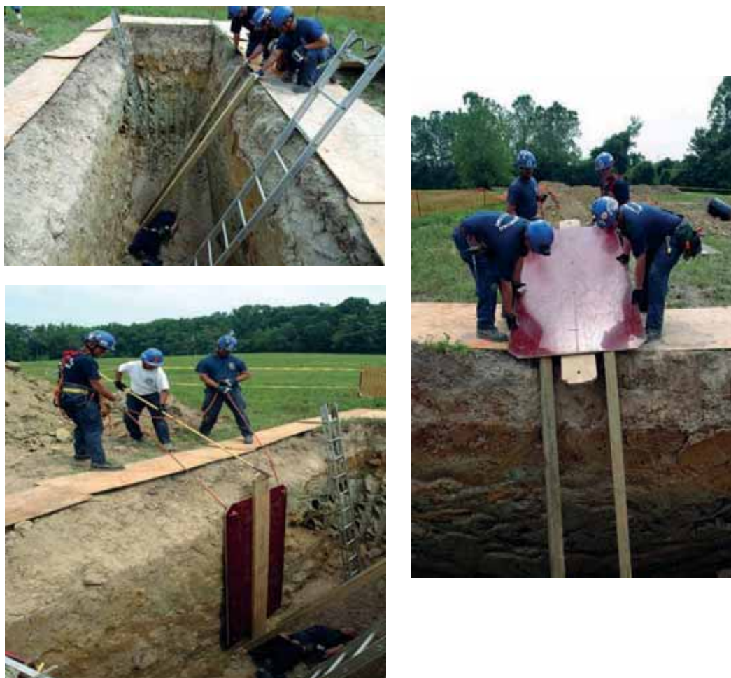
Obrázek 27, Spouštění bednicí desky do výkopu pomocí trámů [1]
