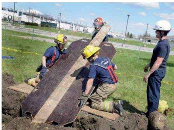
Obrázek 7, Ukázka bednicí desky používané pro záchranu zavalených osob [6]
