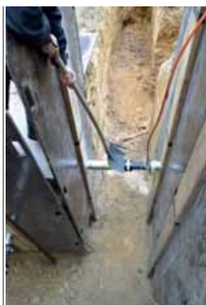
Obrázek 35, Způsoby uvolnění automatické pojistky pneumatické tyče bez vstupu do výkopu [7]
