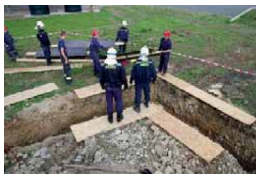
Obrázek 25, Ukázky správného rozložení váhy na hraně výkopu položením nášlapných desek [5], [8]
