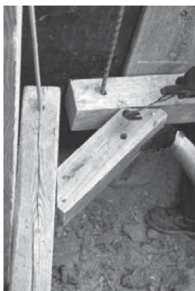
Obrázek 10, Nasazení dřevěných prvků při stabilizaci rohových výkopů [6]
