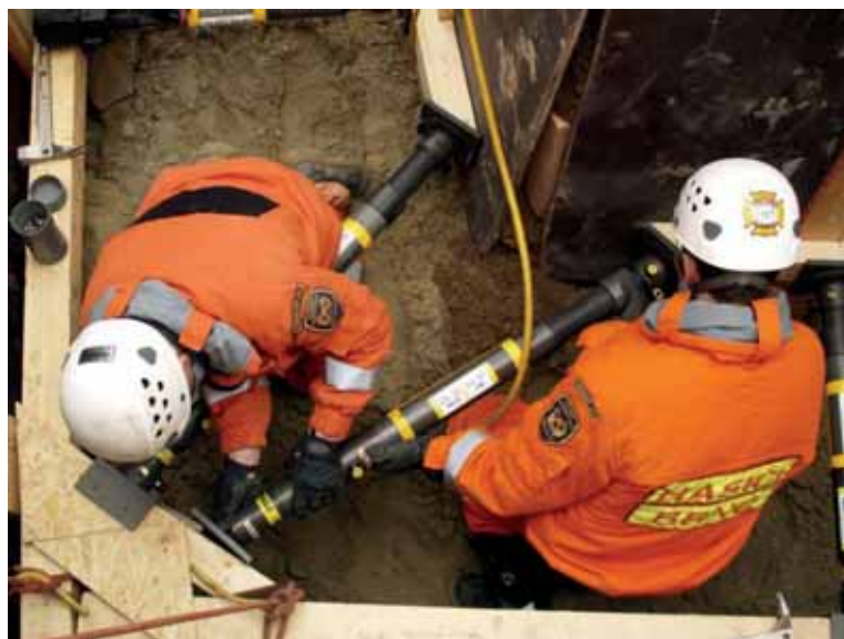
Obrázek 58, Umístění šikmých tyčí v rohovém výkopu [5]
