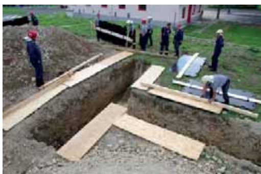
Obrázek 25, Ukázky správného rozložení váhy na hraně výkopu položením nášlapných desek [5], [8]
