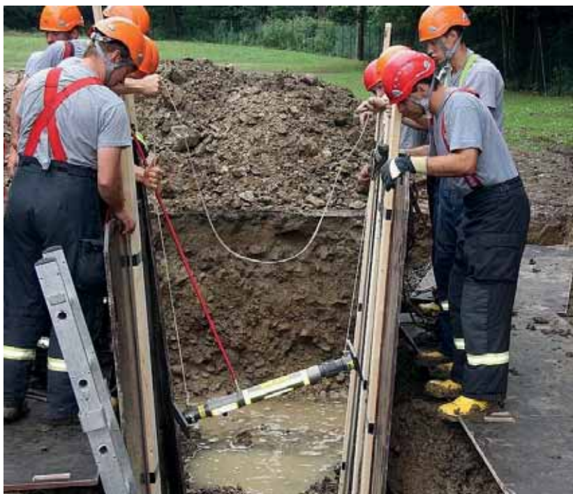
Obrázek 18, Použití reep šňůr ke spuštění stabilizační tyče do výkopu [5]
