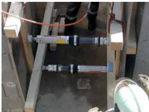
Obrázek 33, Nasazení středové stabilizační tyče do bednicí desky [5]
